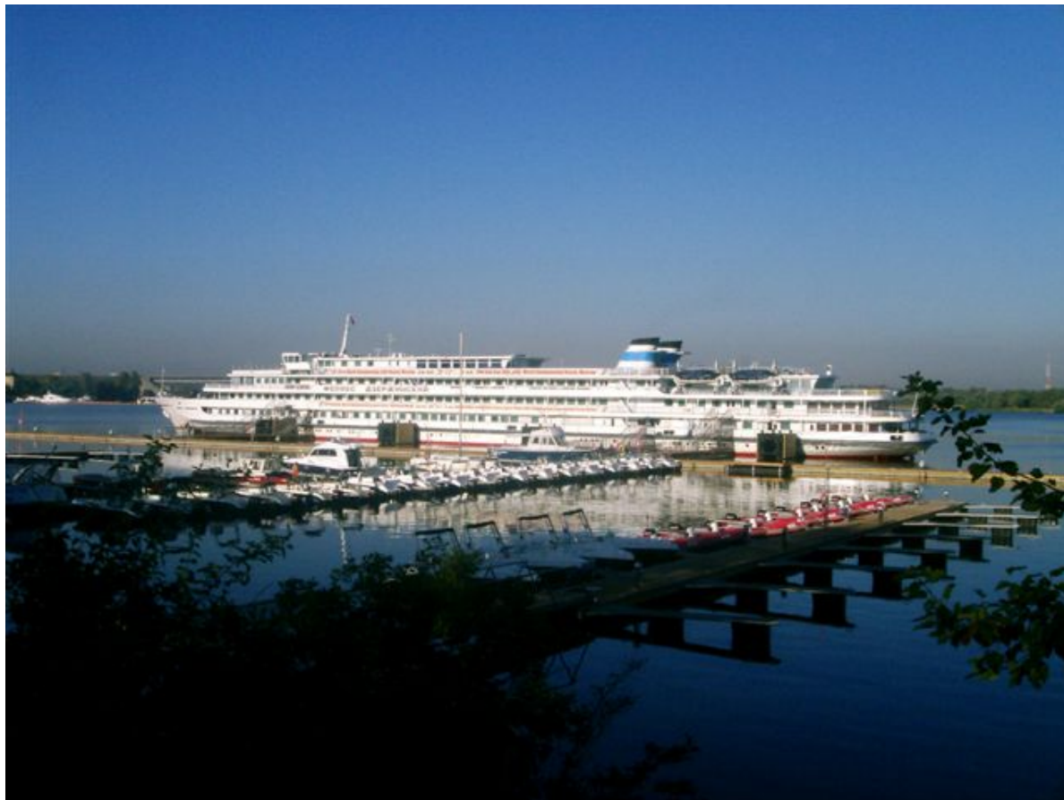
Гидротехнические сооружения ГОУ "ЭШВСМ Москомспорта" по парусным видам спорта / Фотография предоставлена АО "Гипроречтранс"
