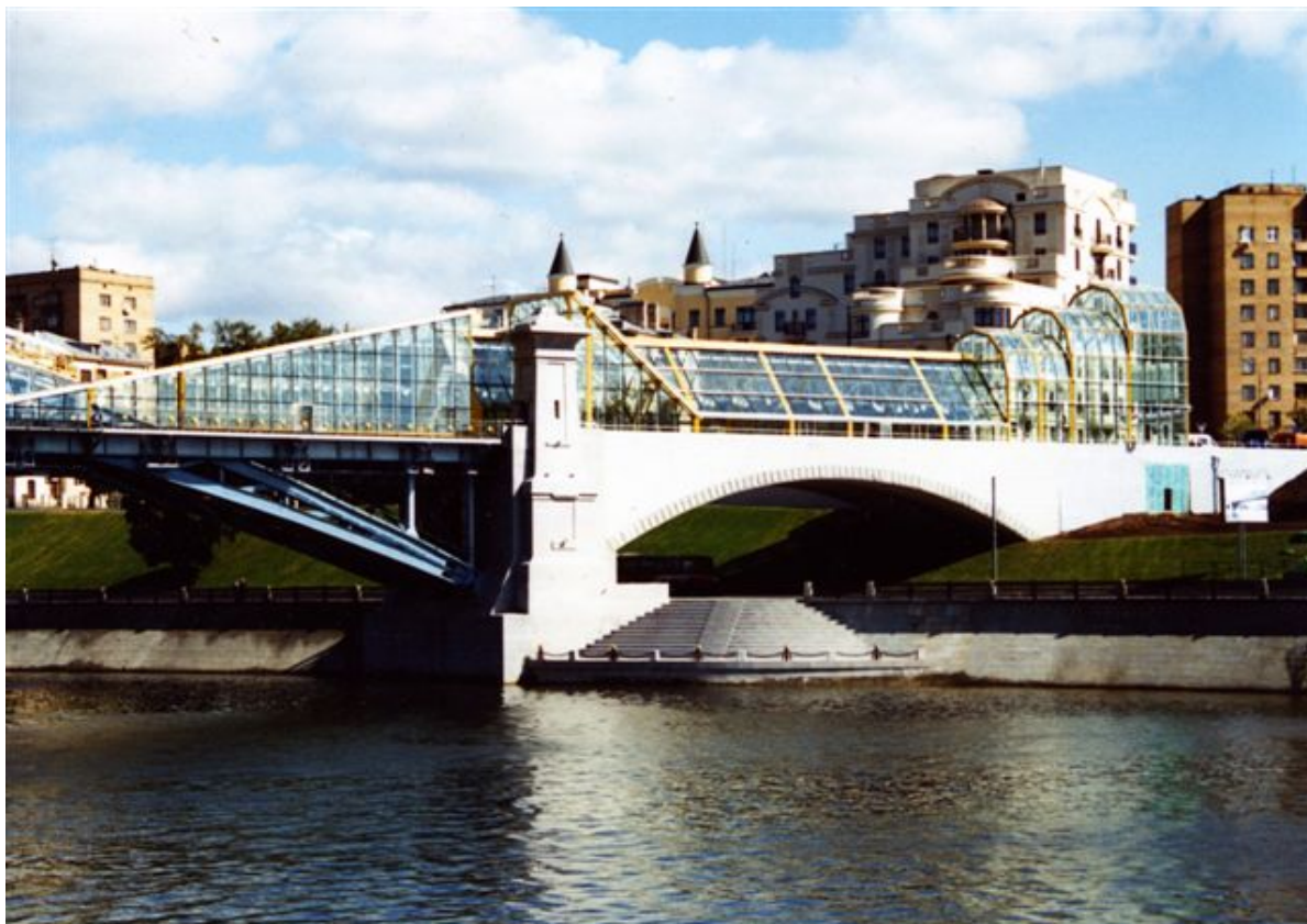
Набережная Киевского пешеходного моста в Москве / Фотография предоставлена АО "Гипроречтранс"
